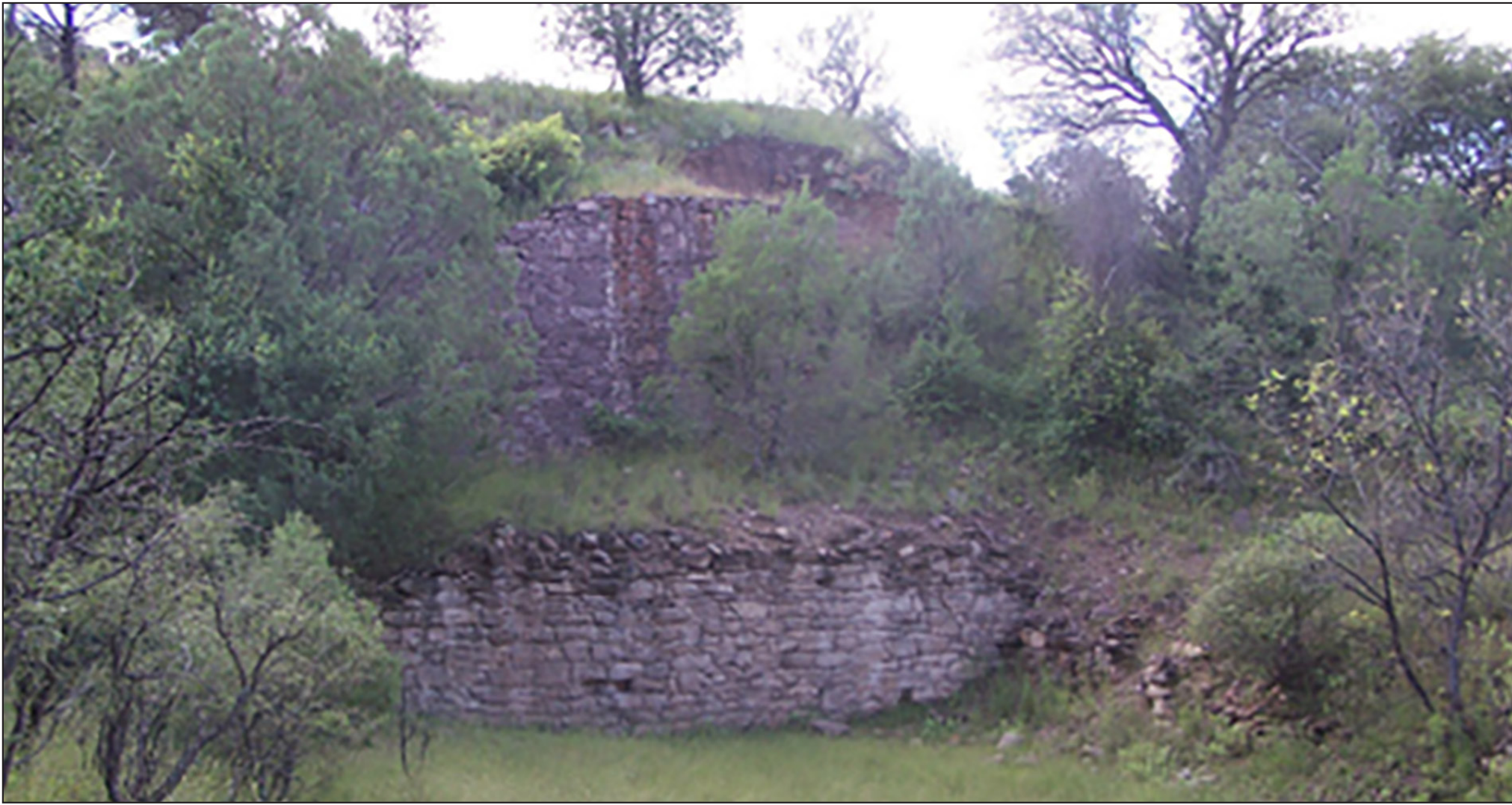
Muros de contención aterrazados
